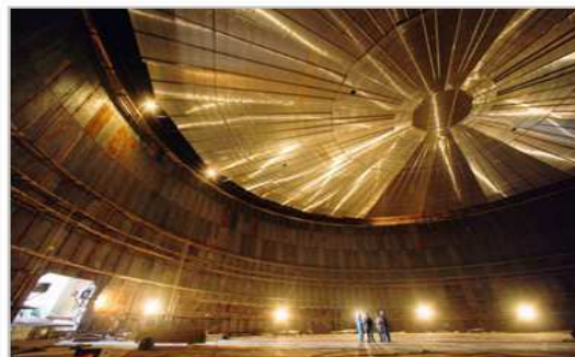
Εσωτερική απεικόνιση δεξαμενής ενός LNG πλοίου
