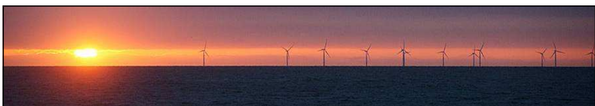
Υπεράκτιο αιολικό πάρκο στη Βόρεια Ουαλία
